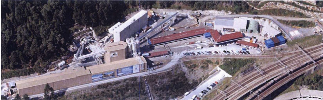
Figura 4: Cantiere del Loetschberg - Goppenstein (portale della discenderia di Ferden)
