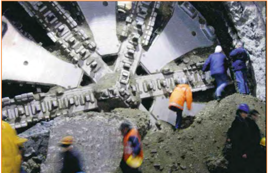
Figura 35 - Particolare fronte di scavo TBM
