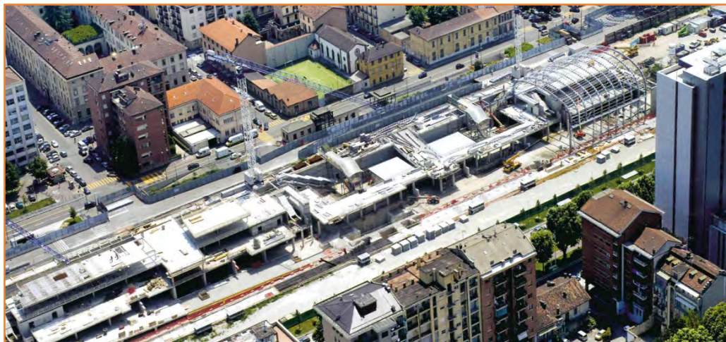
Figura 38 - Il cantiere del Passante Ferroviario di Torino
